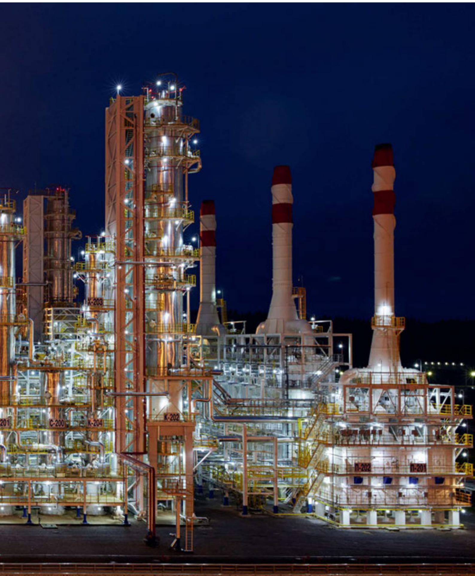
Усть-Луга, установка фракционирования СГК. Ноябрь 2013
