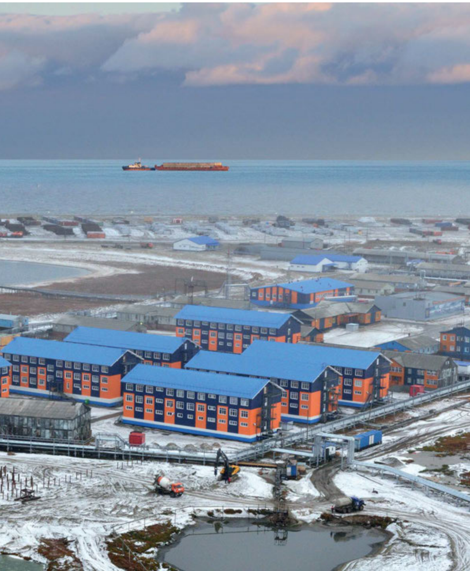
Ямал СПГ, вахтовый поселок и склад материалов. Сентябрь 2013
